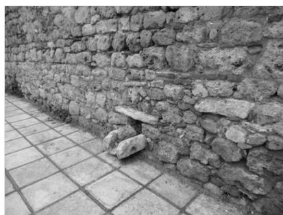
Τμήμα λίθινου αγωγού που διέρχεται από το πάχος της τοιχοποιίας ψηλού κτιστού περιβόλου ιδιοκτησίας που βρίσκεται επί της οδού Καββαδία στη Βέροια.
