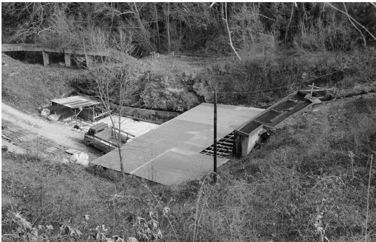
Εικόνα 1: Οι δεξαμενές νερού
